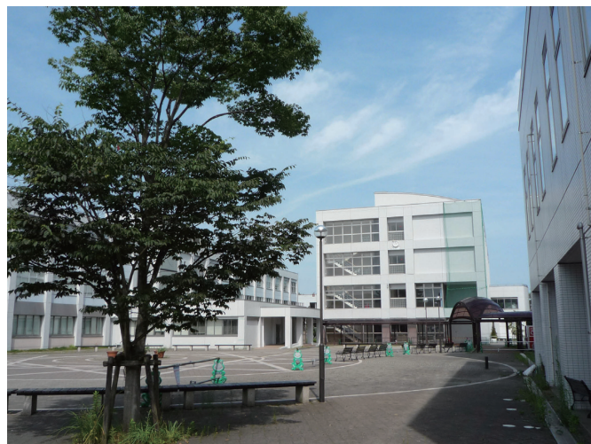
現在の校舎 専門棟と総合棟の中庭（中央は高学年棟）
