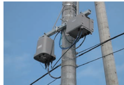
▲配電自動化システム
