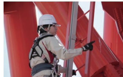
▲通信設備保守作業の様子
