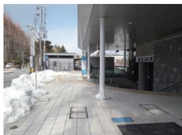
国際センター駅の融雪状況
