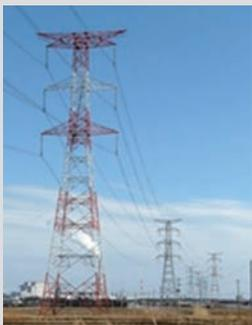
鉄塔には基本仕様がありますが、電線の入り方によって形も変わり、建設地の地形によっても構造は変わってきます。
