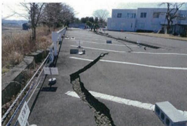
Fig.2 キャンパス南側の地割れと地盤沈下
