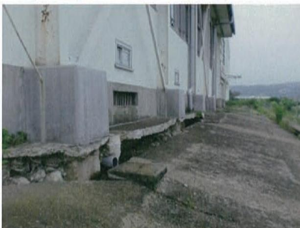
Fig.3 建替えが決定した武道場北側の地盤沈下
