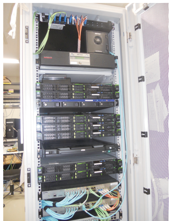
教育用コンピュータシステムを格納するラック（広瀬キャンパス）
