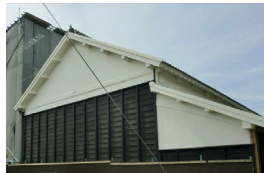
Fig.1 熊本藩川尻御蔵の建築遺構
